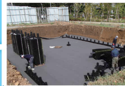
3 ユニット組立／底部ユニット敷設
