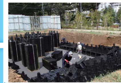
4 ユニット組立／本体ユニット組上げ
