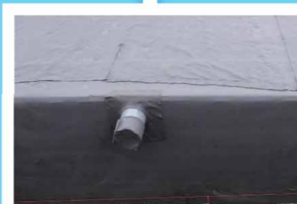
8 流入口/管口取付け状況
