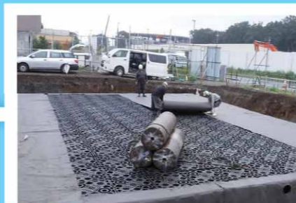
9 上部透水シート 敷設
