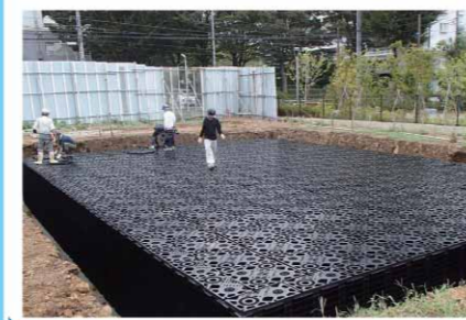
5 ユニット組立／天板敷設
