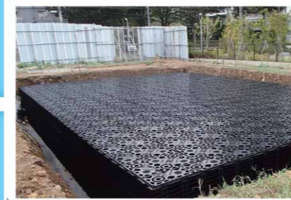
6 ユニット組立／完了・出来高確認
