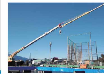
クレーン重機（現場支給）
