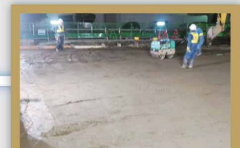
11 埋め戻し／舗装仕上げ
