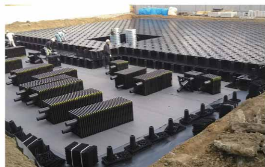
▲ スポーツ施設 / テニスコート下設置
