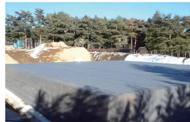
▶ ゴルフ場 / 芝散水用貯水槽
