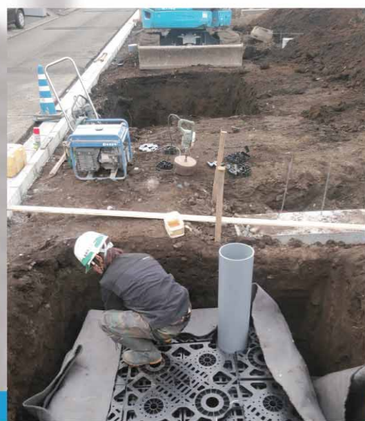
▲ 宅地造成 / 各戸分散方式、ガレージ下設置
