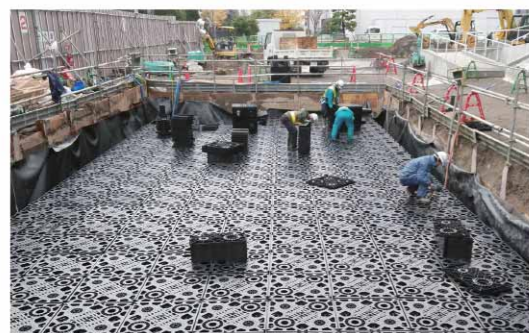
▲ 物流施設 / 大型トラック搬入路下設置
