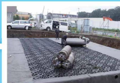
9 上部透水シート 敷設
