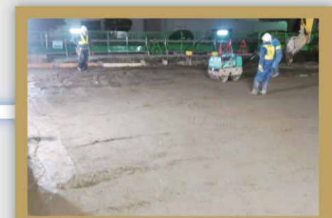
11 埋め戻し／舗装仕上げ
