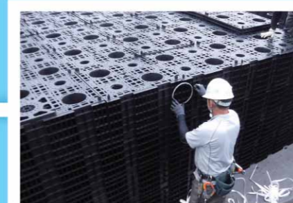
7 流入(流出)口/管口加工 (現場支給)
