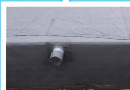
8 流入口/管口取付け状況
