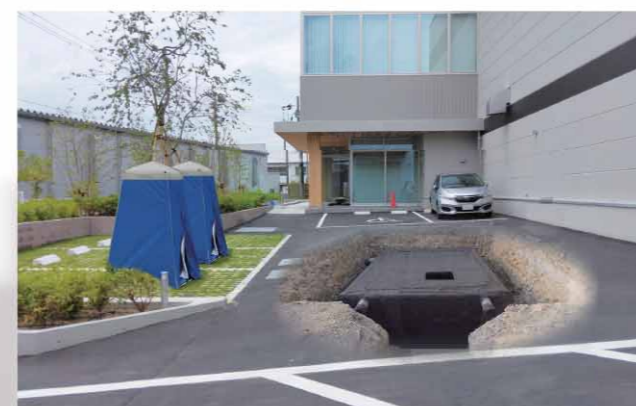
▶ 災害用マンホールトイレ用水
