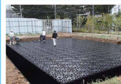
5 ユニット組立／天板敷設
