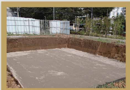
1 掘削／基礎工事
