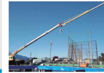
クレーン重機（現場支給）
