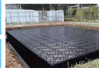
6 ユニット組立／完了・出来高確認
